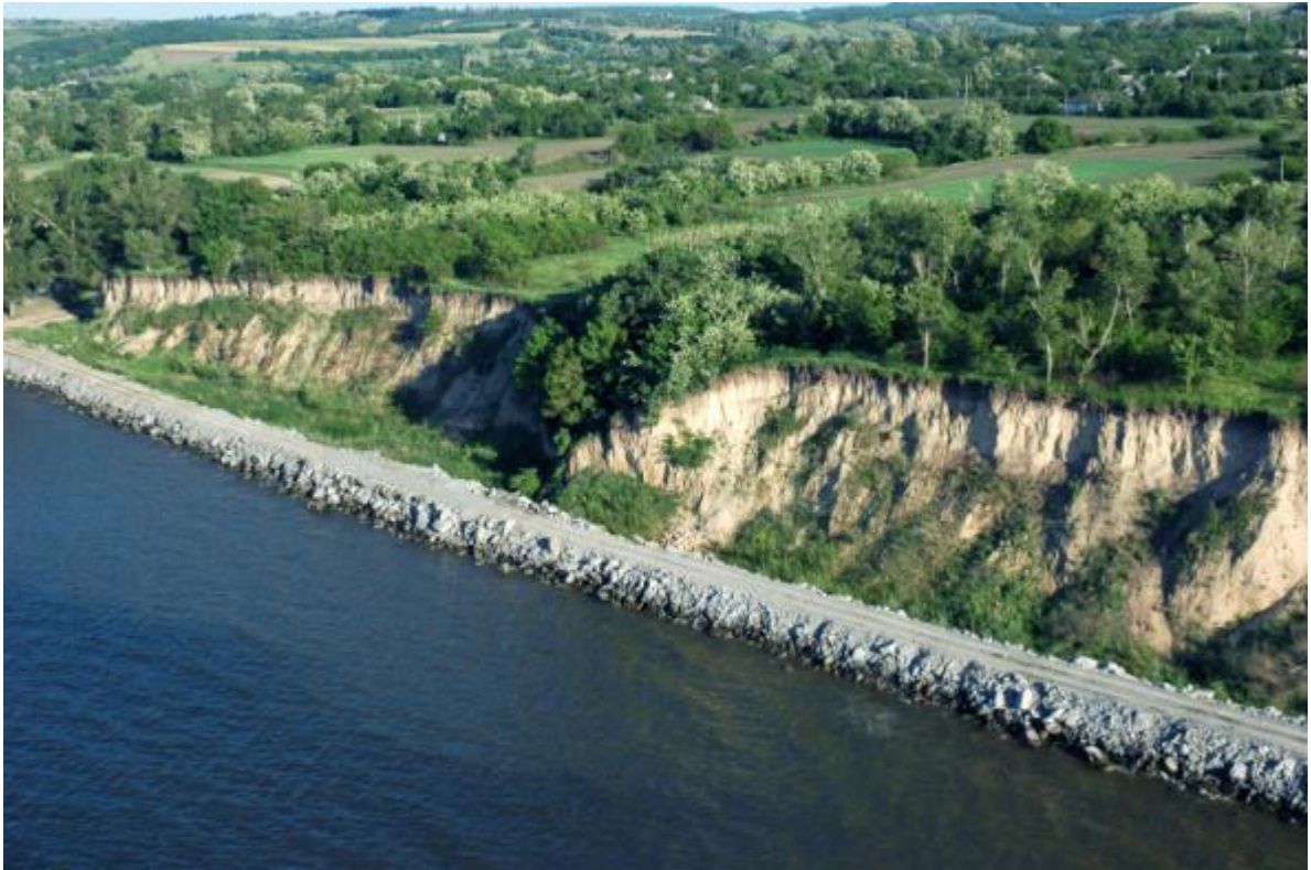
Берегоукріплення Кременчуцького водосховища
