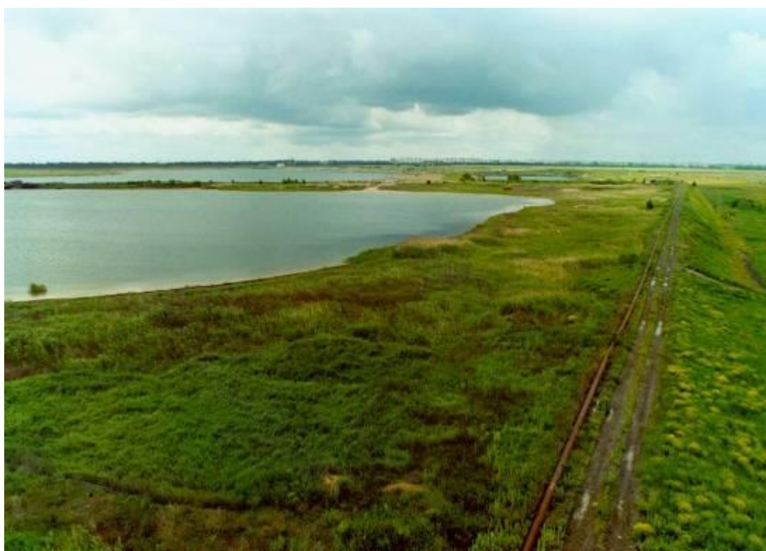
Хвостосховище (загальний вигляд) балка “Щербаківська” ДП Східний ГЗК
