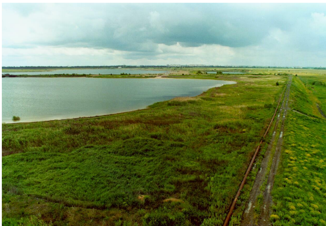
Хвостосховище балка «Щербаківська» ДП Східний ГЗК
