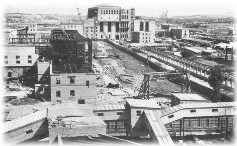
Будівництво ТЕЦ, 1952 р.
