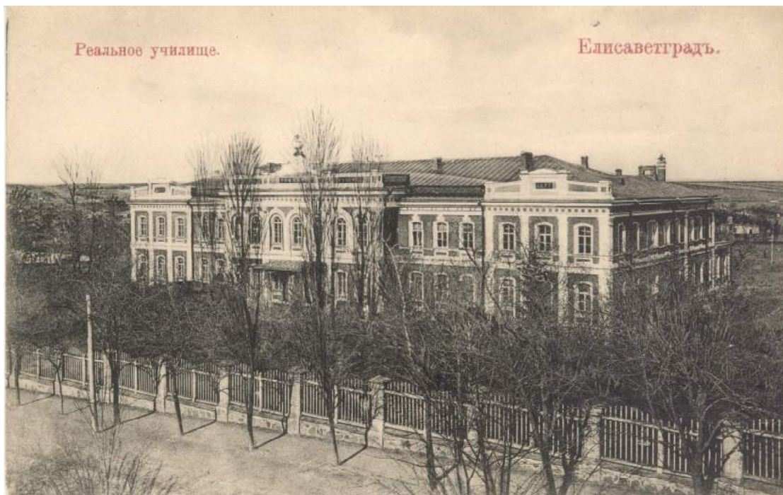
Земське реальне училище. Поштова листівка. Атикові пояси над центральним ризалітом та ризалітами по краях головного фасаду будинку
