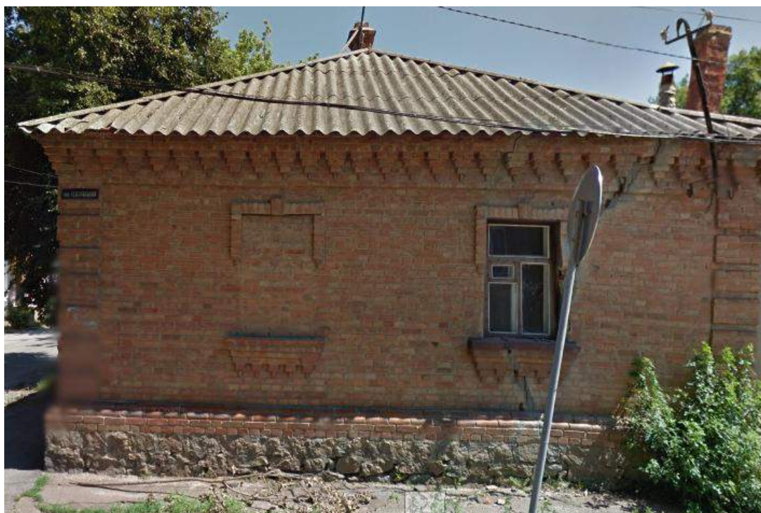
Будинок № 17 по вулиці Нейгауза.
