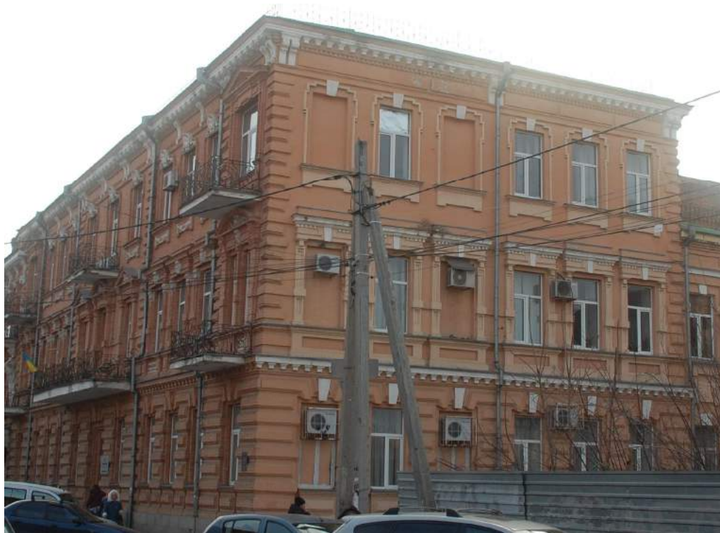
Будівля поштамту по вулиці Гоголя, фасад від провулку Декабристів. «Сліпі» вікна на другому та третьому поверхах.
