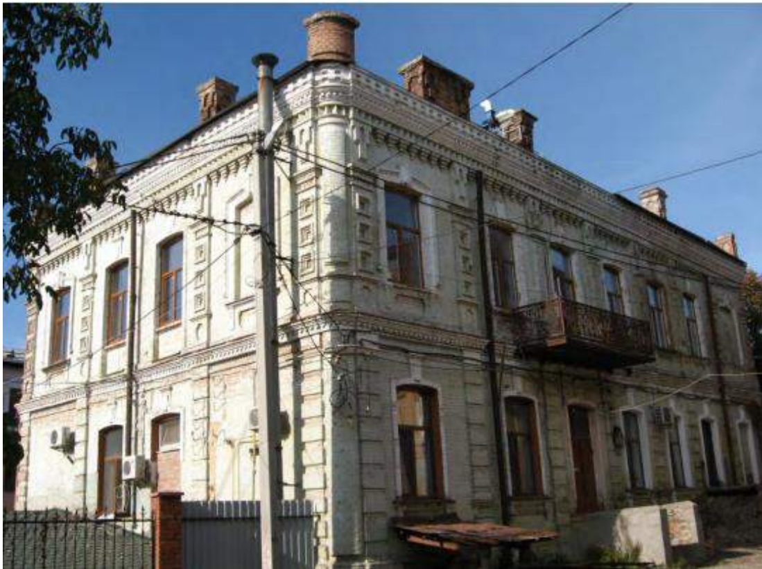
Двоповерховий будинок № 1 по вулиці Панченка, на розі з вулицею Шевченка, неатрибутований. На дворових фасадах присутні «сліпі» вікна.
