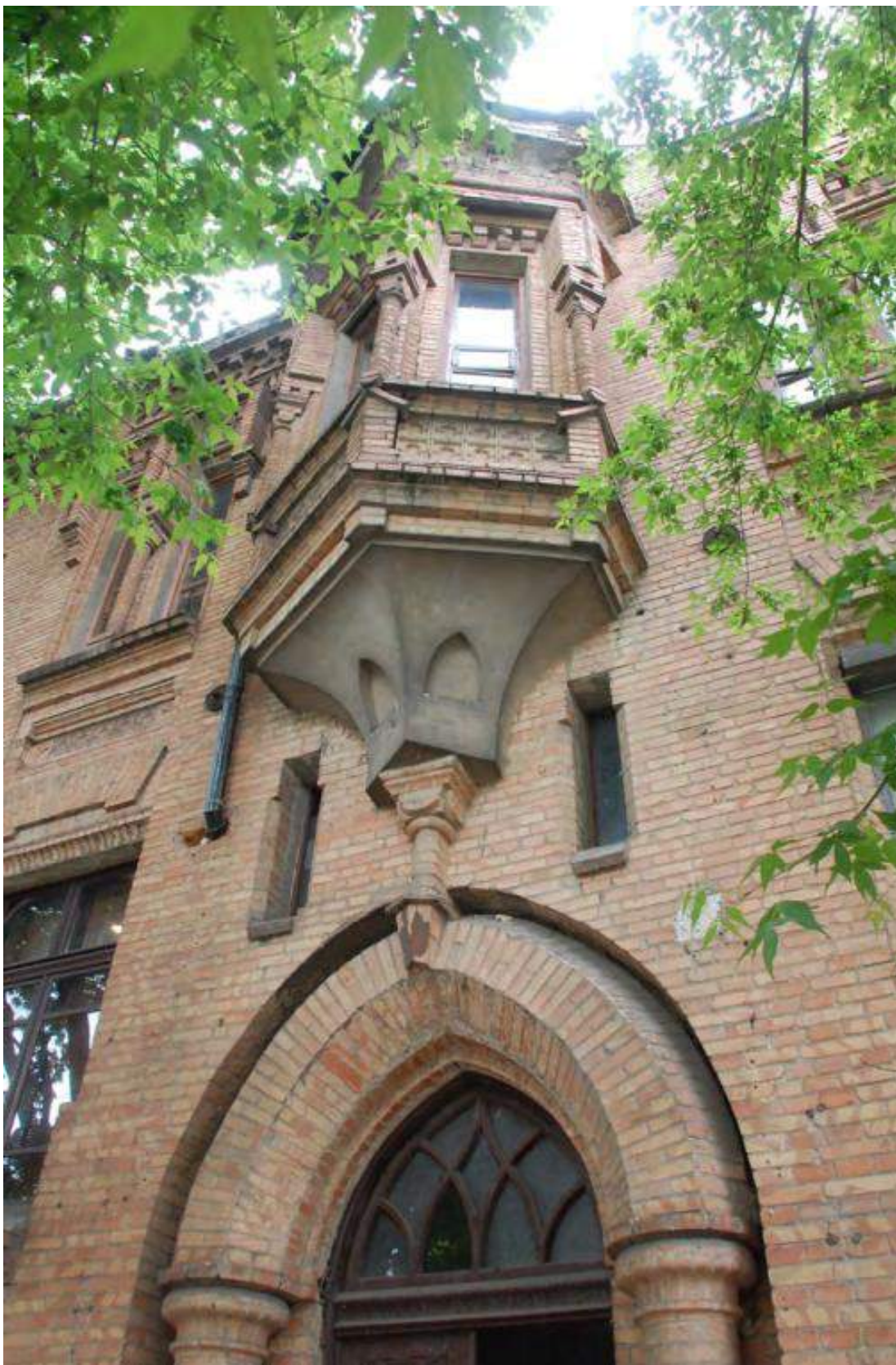
Двоповерховий будинок № 68 по вулиці Шевченка, неатрибутований. Між порталом та еркером два вузьких продовгуватих прямокутних вікна для освітлення сходового майданчика.
