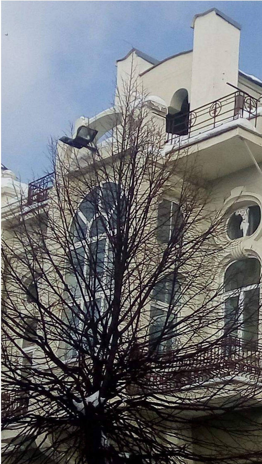
Будинок № 11 по вулиці Дворцовій. Над центральним входом - еркер, у бокових площинах якого двері, що виходять на балкони. Над цими дверима – фігурне вікно другого світла.
