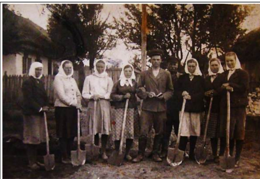
На спорудженні автомобільної дороги від Олександрівки до Знам'янки бригада колгоспниць з с.Красносілка Олександрівського р-ну. Їхньої згоди працювати там ніхто не питав. Кінець 40-х рр. З колекції М. Коломійця
