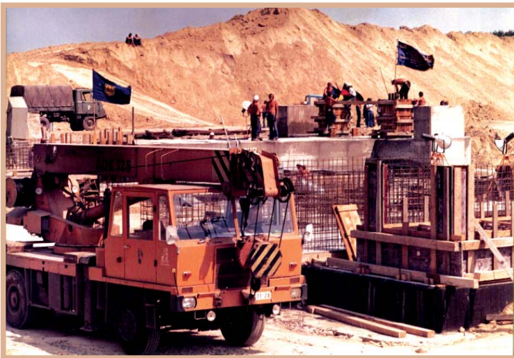
На будівництві газопроводу
