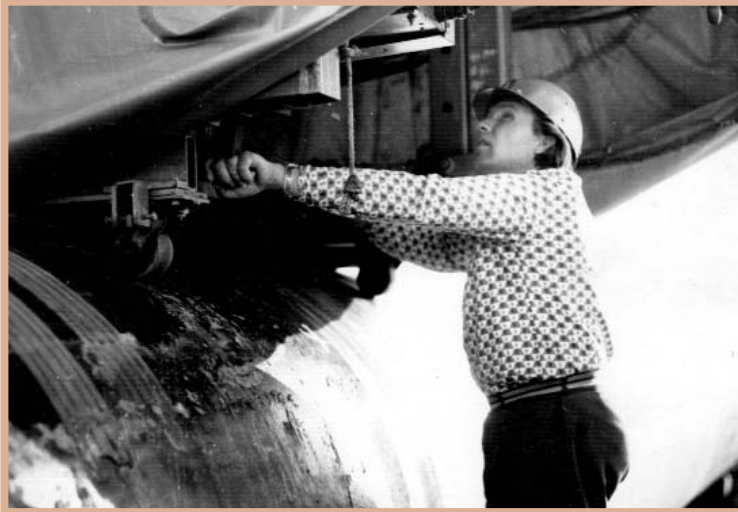
Зварювальні роботи на будівництві газопроводу
