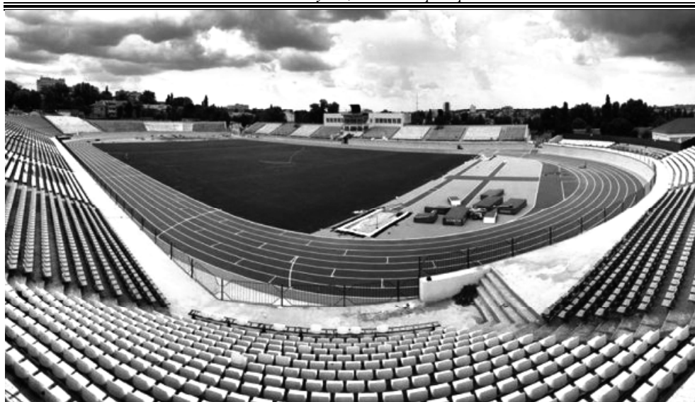
Такий вигляд має стадіон "Зірка" після реконструкції
