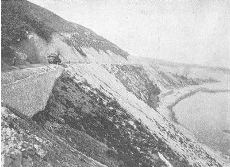
Могилевская ветвь. Подпорная стенка по р. Днестру.
